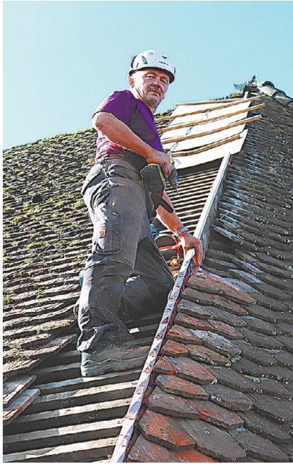
Zimmermann René Weiss an der Nordwestecke, wo neue Kupferbleche künftig das Wasser abhalten sollen.
