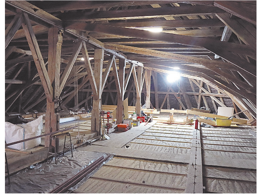
Der Estrich über dem Kirchenschiff dient den Zimmerleuten als vorübergehende Werkstatt.
